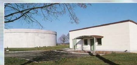
Vue générale du bâtiment filtration.
