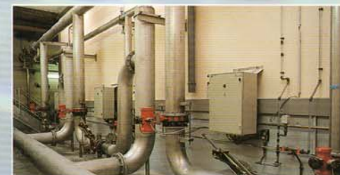
Façade des filtres.
